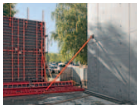
Korrastatud vuugi- ja ankruvõrgustik puhastel betoonpindadel. Kaubanduskeskus Outlet-Center, Metzingen
