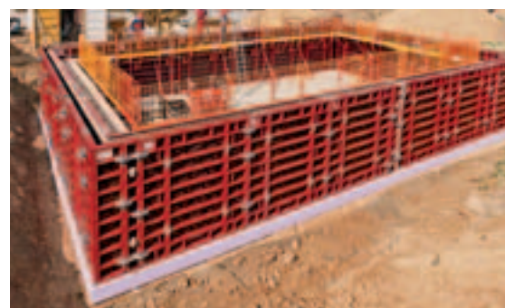
Lühike ehitusperiood - kõrge turvalisuse aste. MAXIMO seinaraketis koos töölavakonsoolidele paigaldatud PROKIT võrkpiiretega. Eramaja kelder, Weißenhorn
