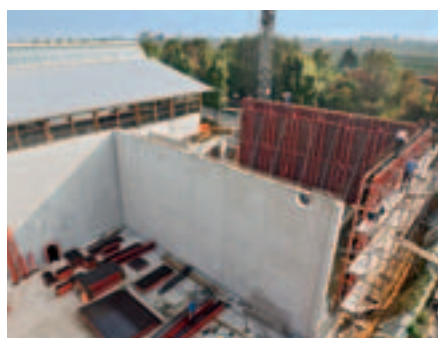
Kõrged, puhta betooni pinnad Rehabiliteerimiskeskus Stuttgart-Fellbachis
