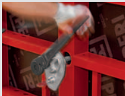
Tõmbi pingutatakse MX tõmbivõtme abil seni kuni rõngaskruvi positsioneeritav on.
