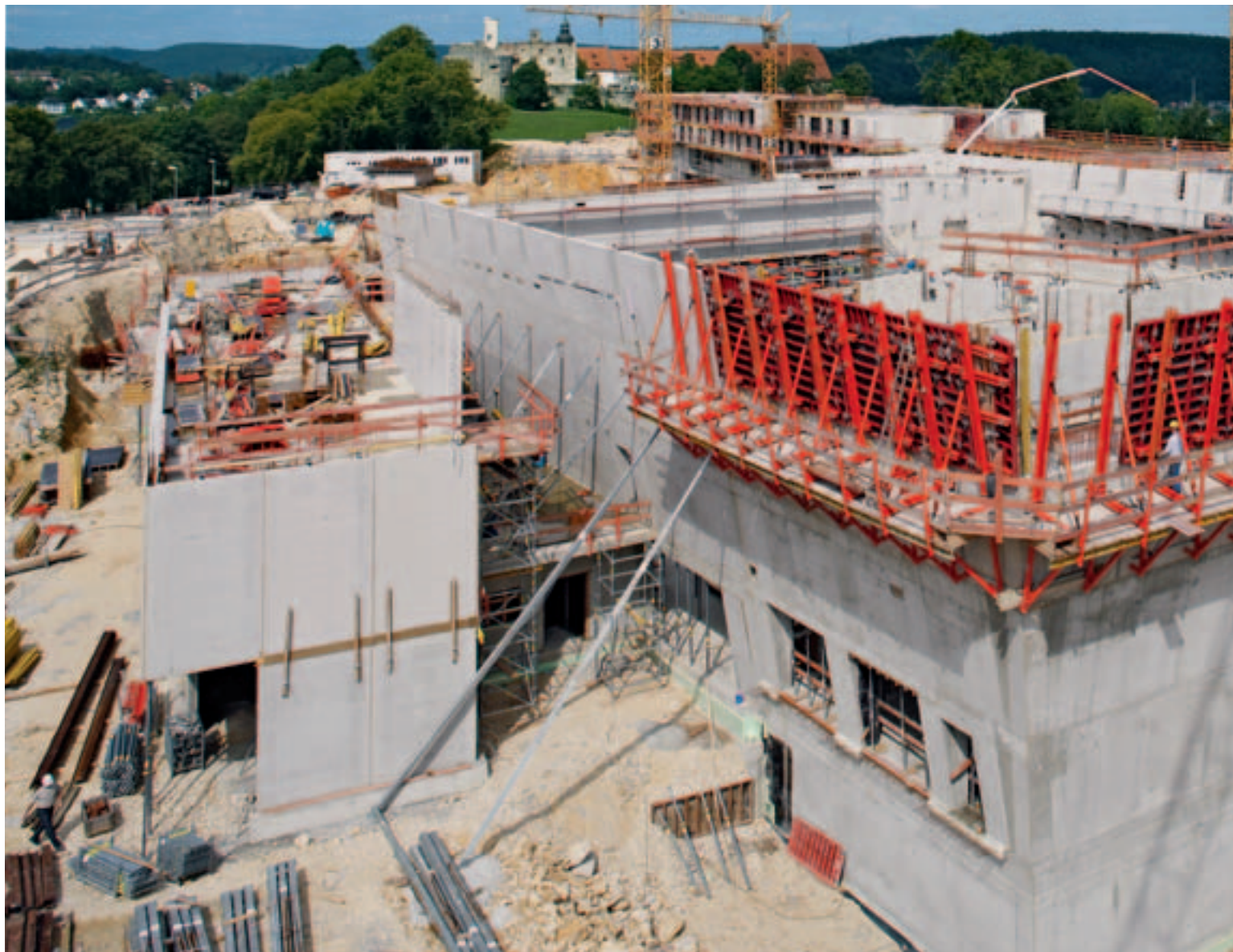
Lühike ehitusperiood - kõrge turvalisuse aste. MAXIMO seinaraketis koos töölavakonsoolidele paigaldatud PROKIT võrkpiiretega. Eramaja kelder, Weißenhorn
