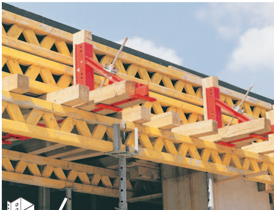
UZ aluslatiga saavutatav liikumatu liide võimaldab UZ nurkade suurt sammu.
