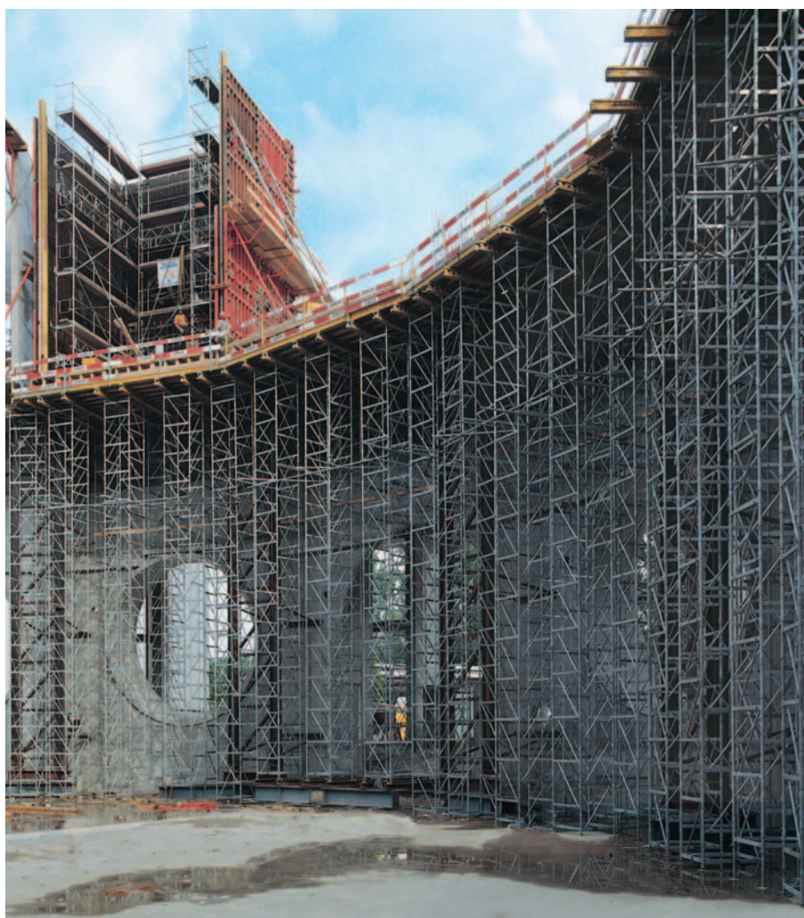
MULTIPROP 350 koos MULTIFLEX laeraketisega.
