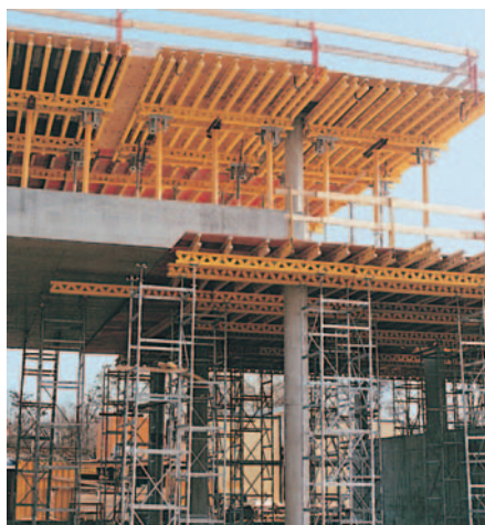
GT 24 talana tugitornile ST 100 toetuvast MULTIFLEX raketises või UNIPORTAL lavaraketises
