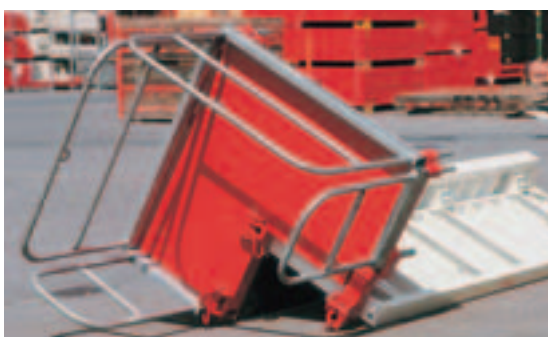
Valamisplatvorm kinnitatakse juba maapinnal raketise külge.
